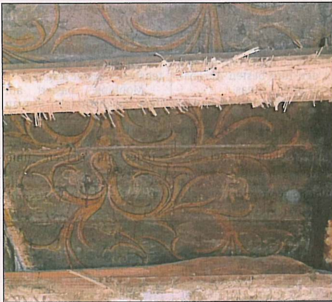
In dem alten Gebäude an der Cappelstraße haben die Denkmalschützer wertvolle, bemalte Holzdecken freigelegt, die vor dem Abriss sichergestellt werden.
