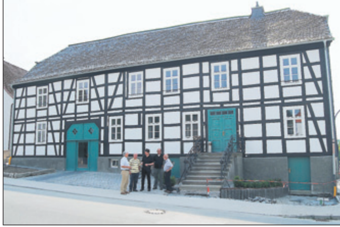
Das Haus Steinrücken 1: An den Außenanlagen wird bis zum 11. Juli noch etwas gefeilt. ■ Fotos: Teichmann
